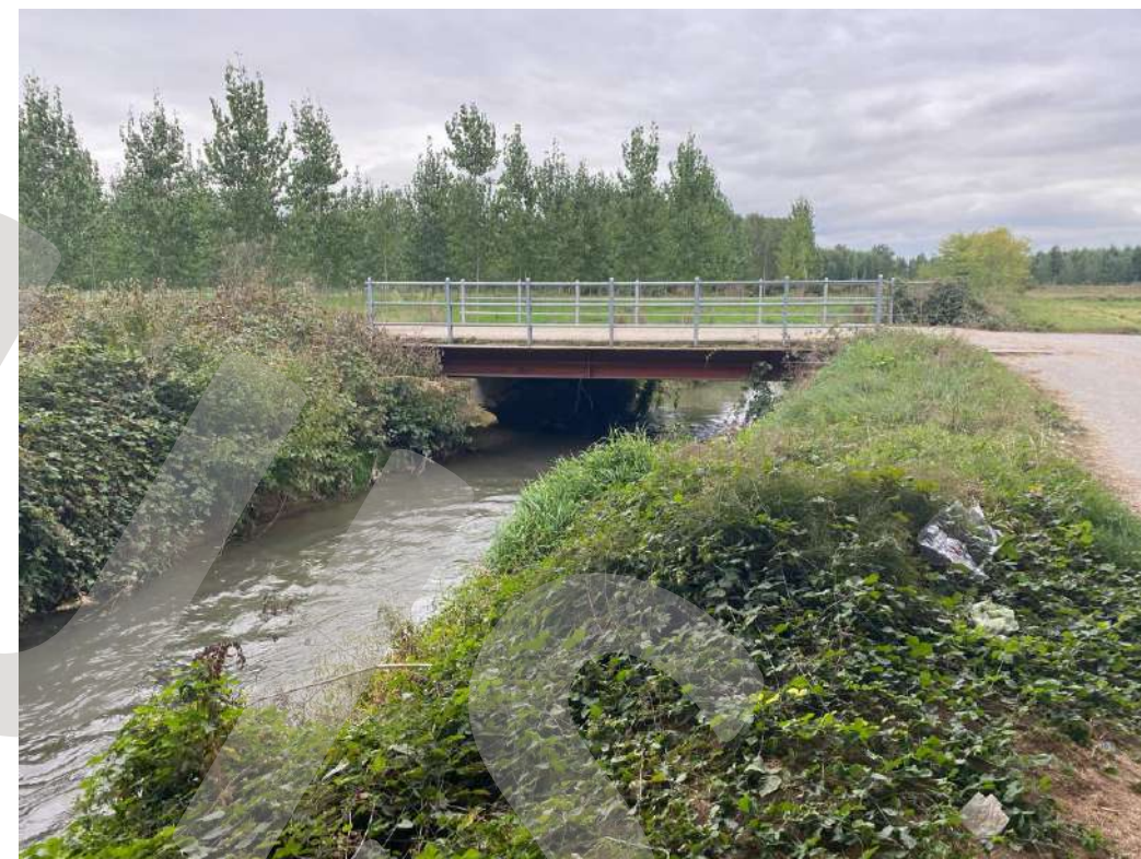
Ponte appena a monte dell'attraversamento analizzato
