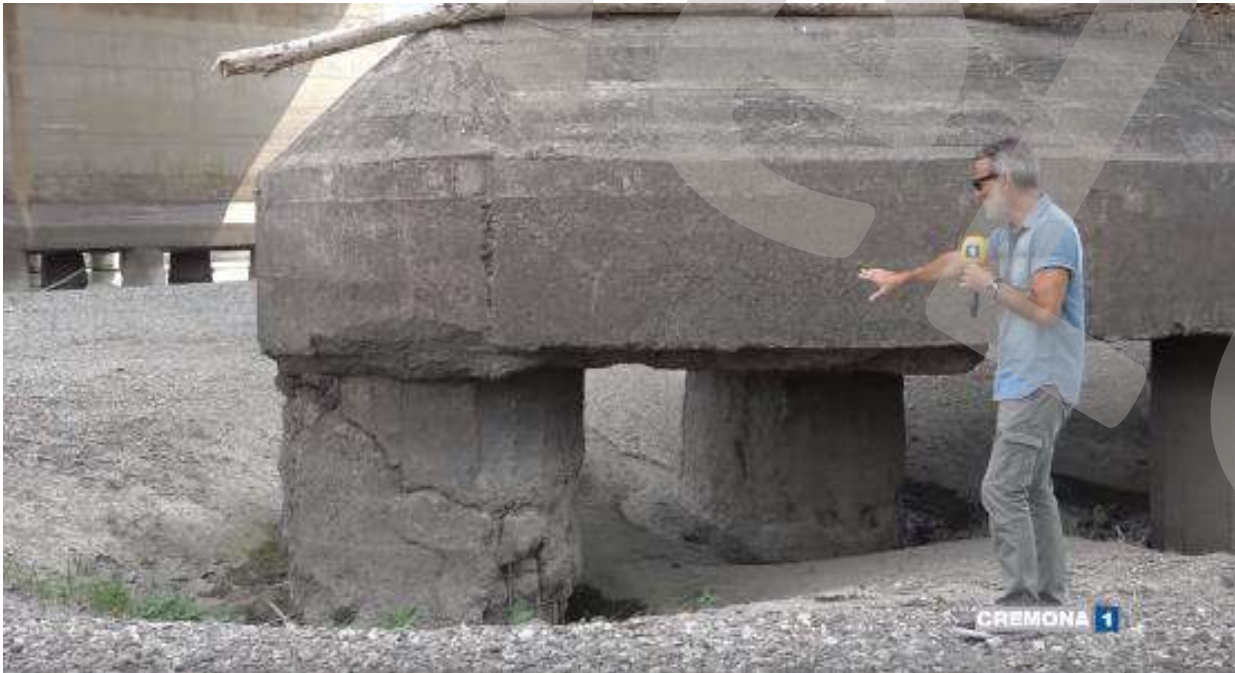
Ponte sul Po in provincia di Cremona
