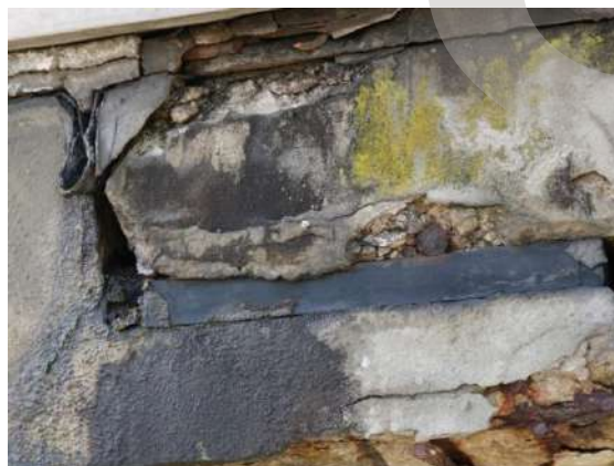
Invecchiamento neoprene (appoggio su sella Gerber)
