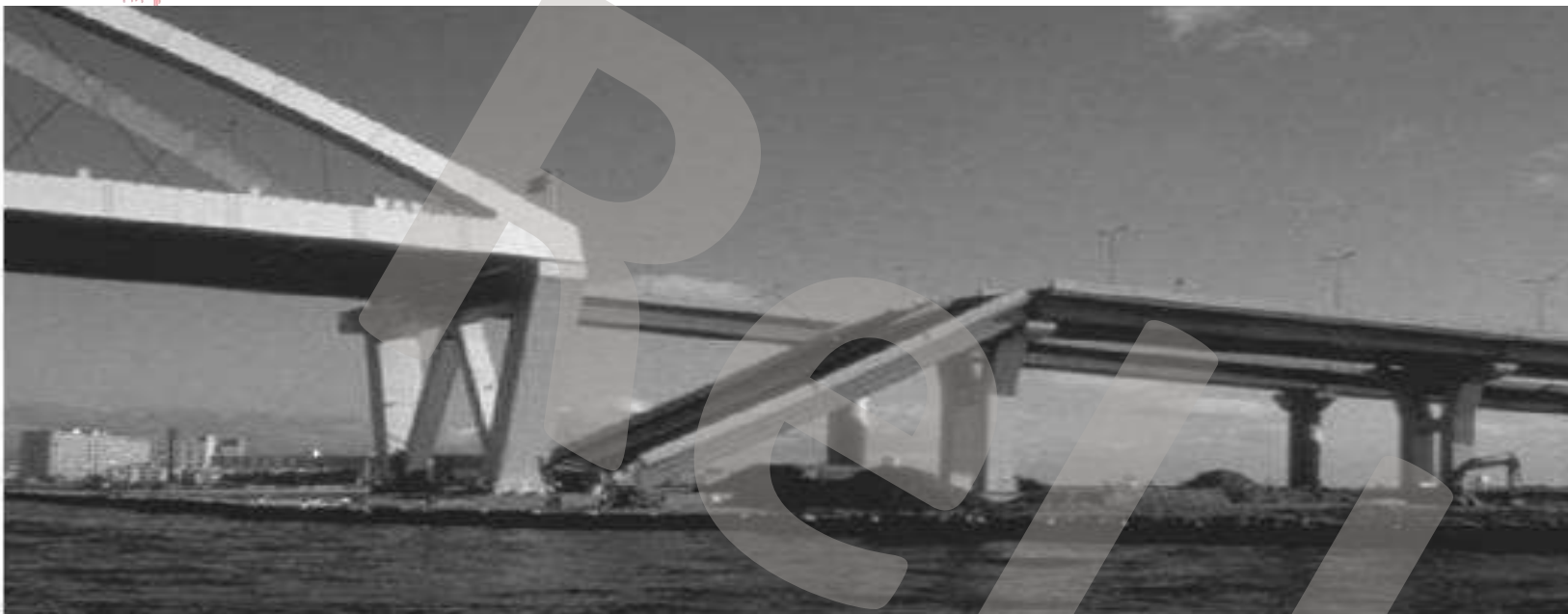
Fig. 1.3 Perdita di appoggio: ponte Nishinomiya-ko, Giappone, Kobe 1995. In questo caso erano presenti ritegni sismici assolutamente inadeguati costituiti da bulloni colleganti le lamiere terminali dell'arco e del traverso della campata crollata.
