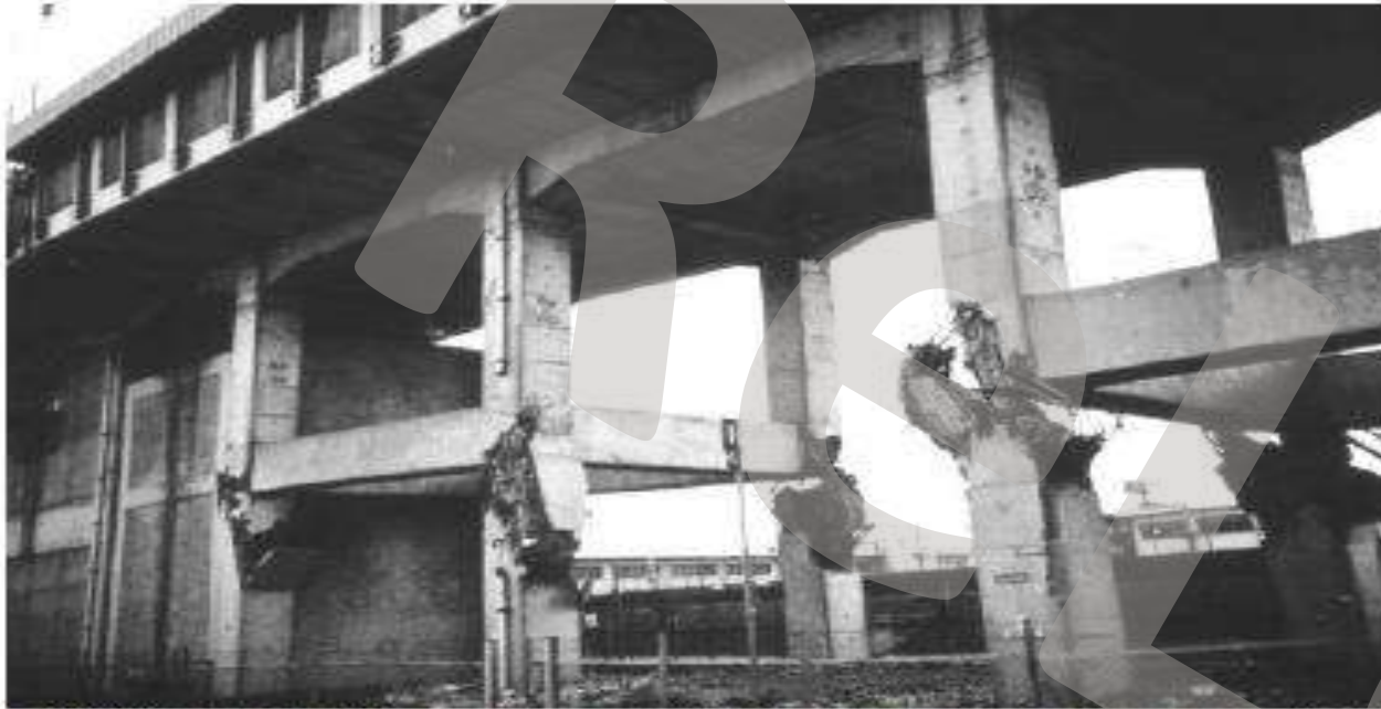
Fig. 1.10 Terremoto di Kobe, Giappone (1995): danni su una pila a telaio, viadotto Shinkansen a Kobe.
