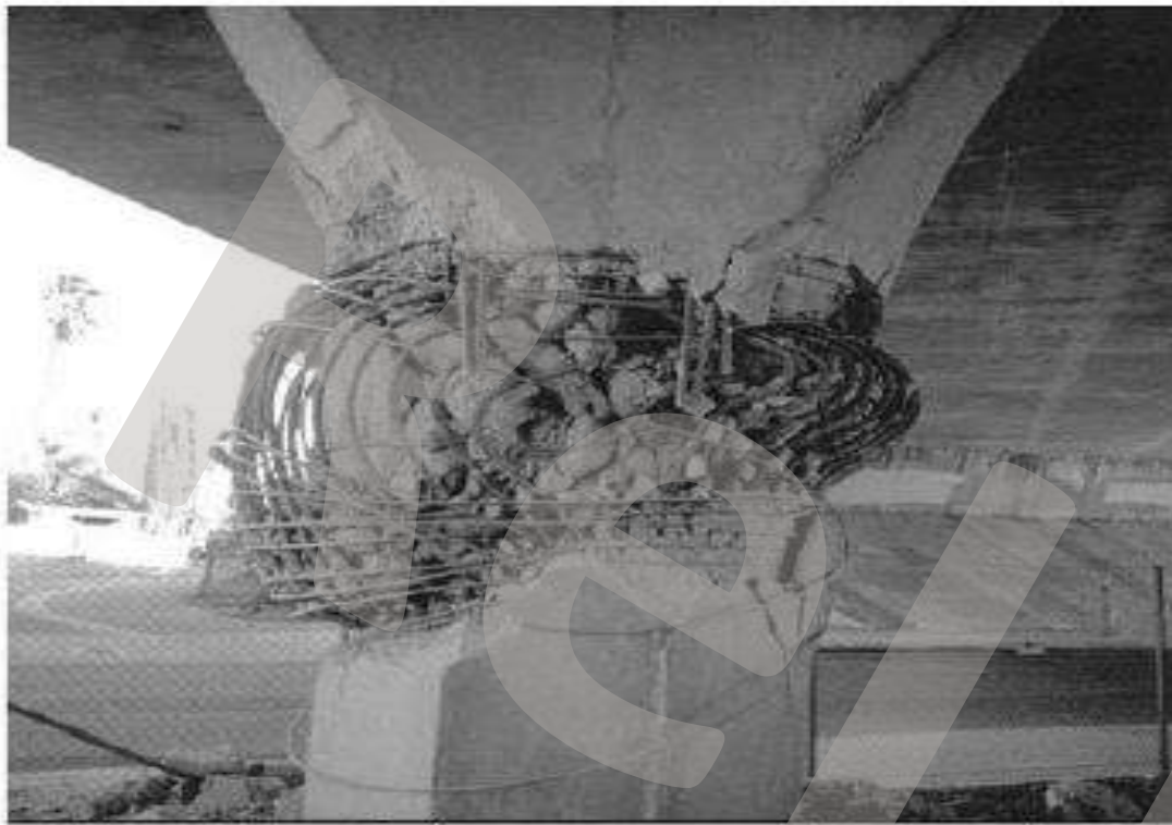
Fig. 1.5 Collasso della cerniera plastica per eccesso di deformazione flessionale ciclica, Viadotto Gothic Avenue (terremoto di Northridge, California, 1994)
