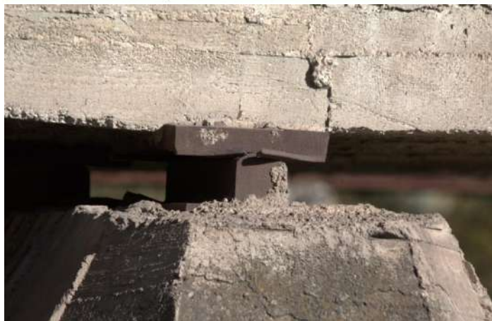
Piastra superiore deformata
