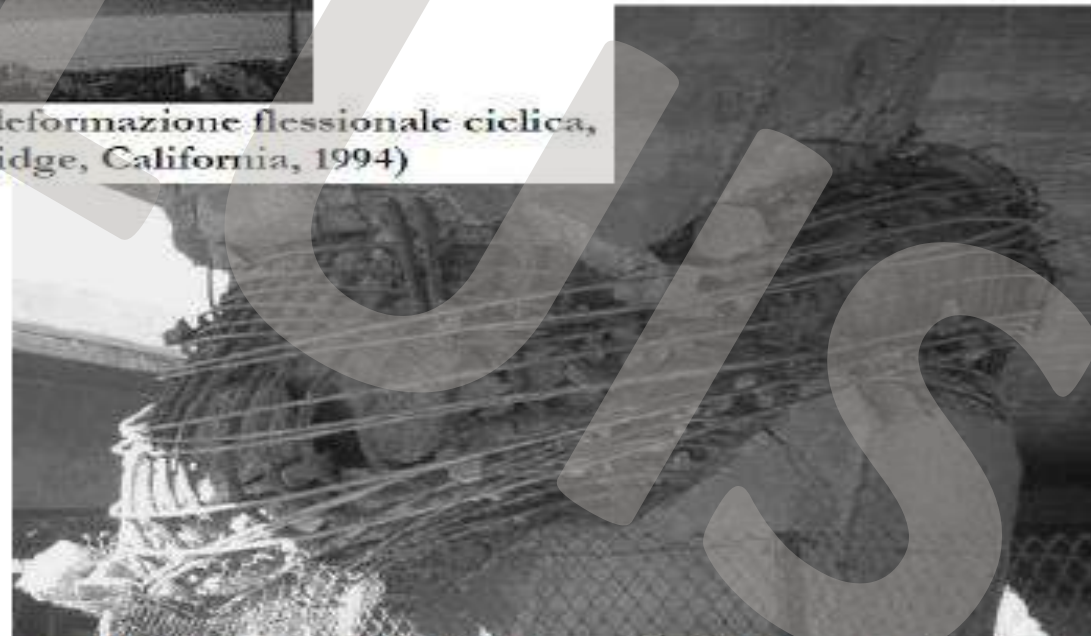
Fig. 1.6 Collasso per flessione e taglio, Viadotto Gothic Avenue (terremoto di Northridge, California, 1994).
