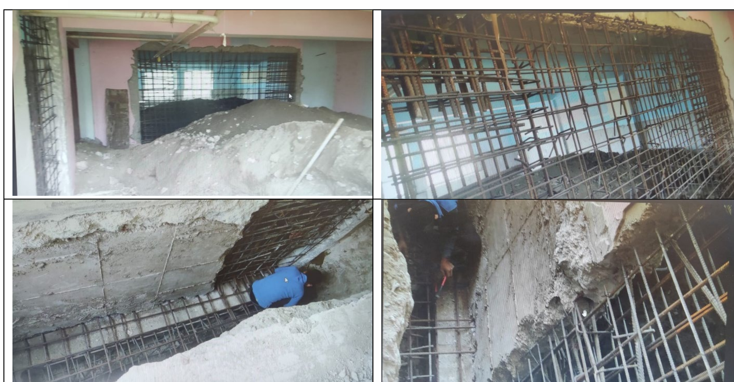
Foto di archivio fornite dall'amministrazione scolastica con illustrazioni delle fasi di intervento di realizzazione dei setti in c.a. posizionati all'interno della maglia strutturale al posto della tramezzatura (a,b), scavo in fondazione per il consolidamento delle stesse (c), dettaglio sulla connessione del setto alla maglia struttura pre-esistente (d).
