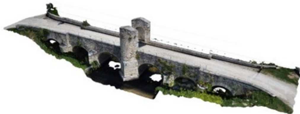
1. Nuvola di punti da laser scanner terrestre (TLS)
