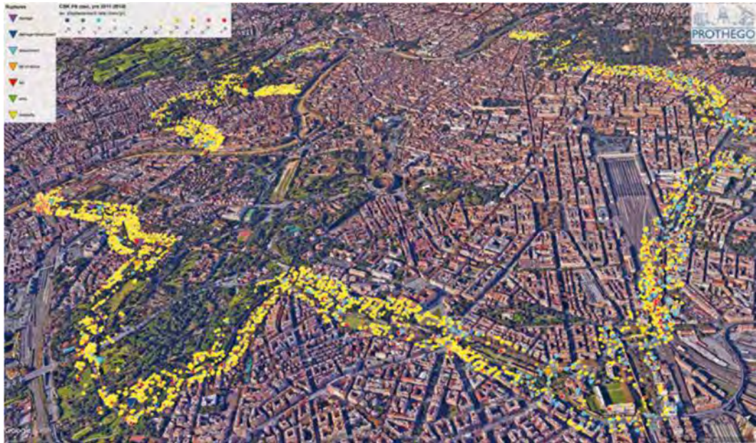
Figura 8-19 Distribuzione dei punti di misura PS e degli eventi di danneggiamento monitorati.
