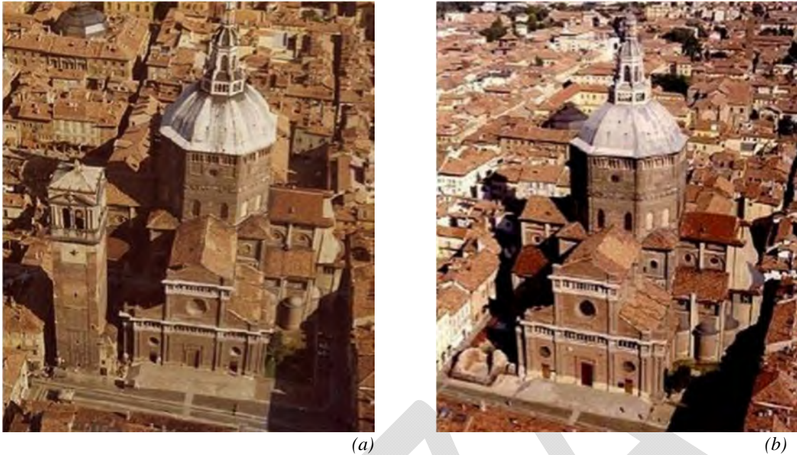
Figura 8-24 – Vista aerea del Duomo di Pavia: (a) prima del crollo della torre civica avvenuto nel 1989; (b) dopo il crollo.
