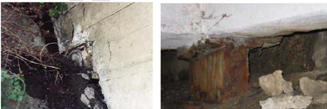
Figura 7-12 – Esempi di difetti sugli appoggi (MIT, 2020).
