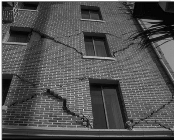
Figura 5-22 – Danno sismico alle pareti murarie, concentrato (a) nei maschi; (b) nelle fasce.
