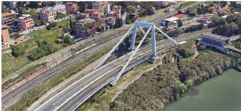
Figura 10-29 – Viadotto Ansa del Tevere (Google Earth).
