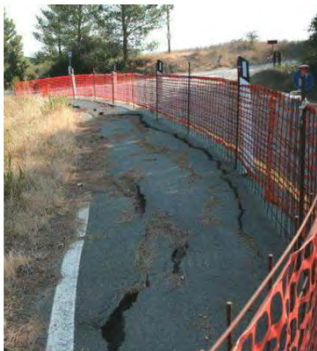
Figura 7-10 – Esempio di danneggiamento dovuto al dissesto del rilevato di approccio – Stabilità, (MIT, 2020).
