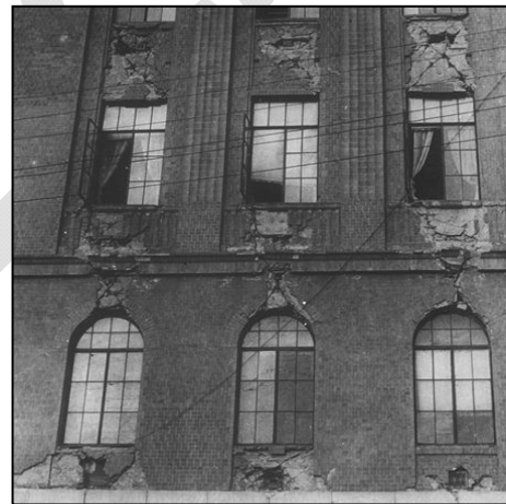
Figura 5-22 – Danno sismico alle pareti murarie, concentrato (a) nei maschi; (b) nelle fasce.
