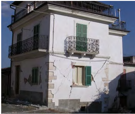
Figura 5-21 – Meccanismi di secondo modo: (a) risposta nel piano delle pareti in un edificio colpito dal sisma dell'Aquila nel 2009, concentrata al piano terra; (b) lesioni a taglio nei maschi del primo piano in una scuola colpita dal sisma del Centro Italia del 2016.
