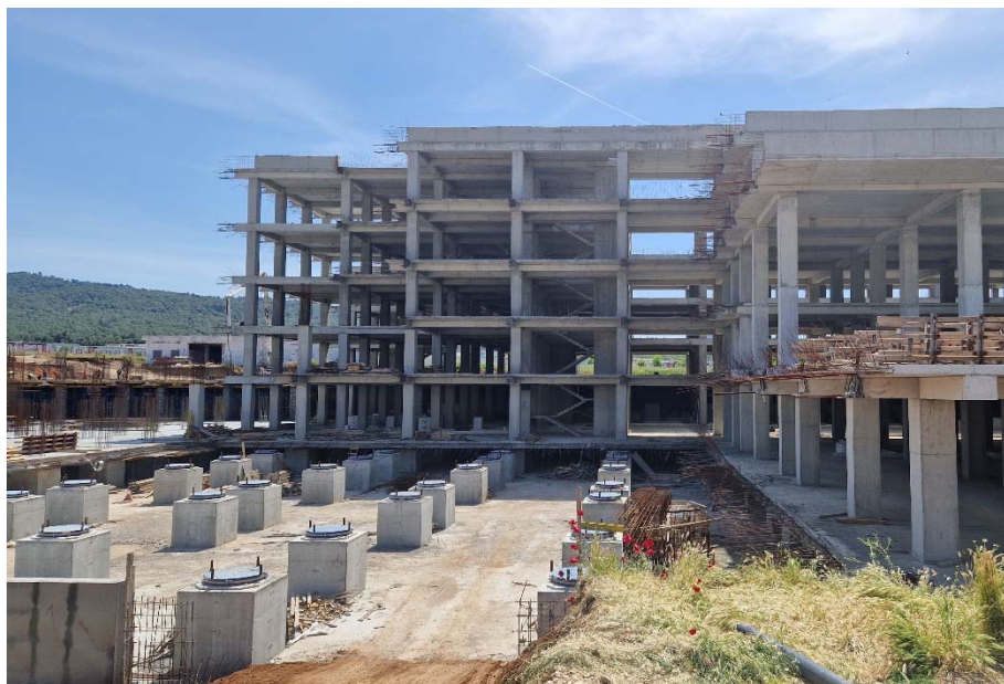
Figura 12 – Vista laterale della struttura in fase di costruzione.
