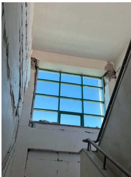
Fig. 14 – Danno osservato sulla struttura esistente
