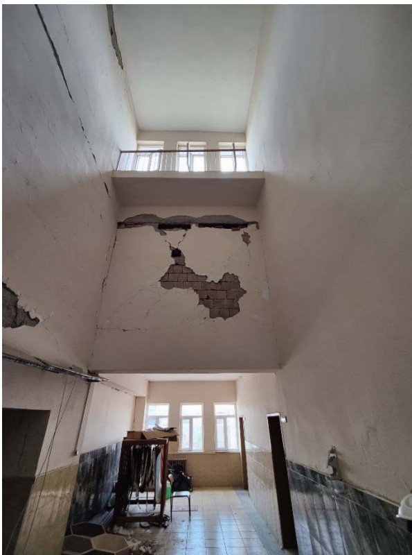
Fig. 6 -Vista frontale dell'edificio, lesione flessionale sulla trave, danneggiamento della tamponatura, danneggiamento della copertura.
