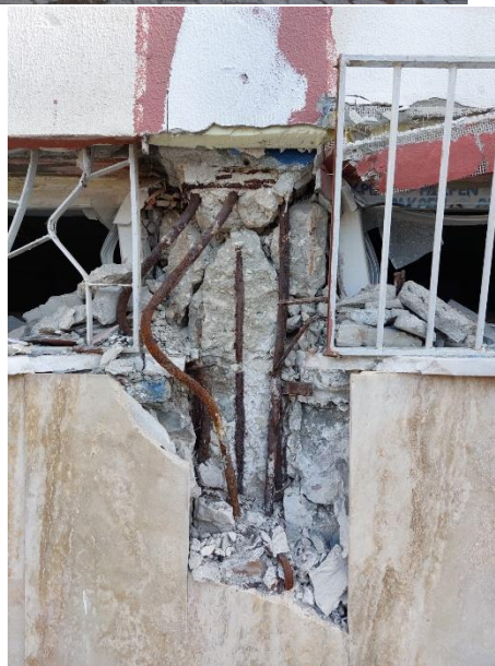
Fig. 5 Danneggiamento in corrispondenza di finestre a nastro di ridotta altezza. (Pilastri tozzi)
