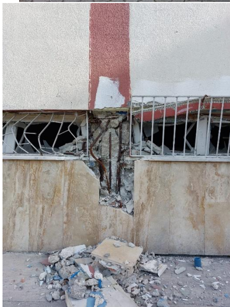
Fig. 5 Danneggiamento in corrispondenza di finestre a nastro di ridotta altezza. (Pilastri tozzi)
