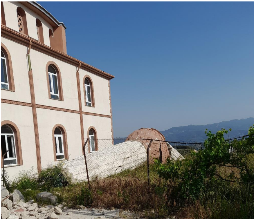
Fig. 12 Crollo a ribaltamento del minaret di moschea.
