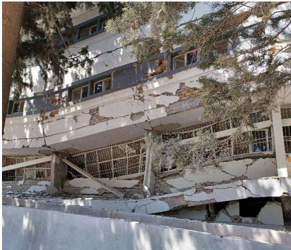
Fig. 17. Collasso edificio per danni a livello dei pilastri del piano terra di un intero blocco.
