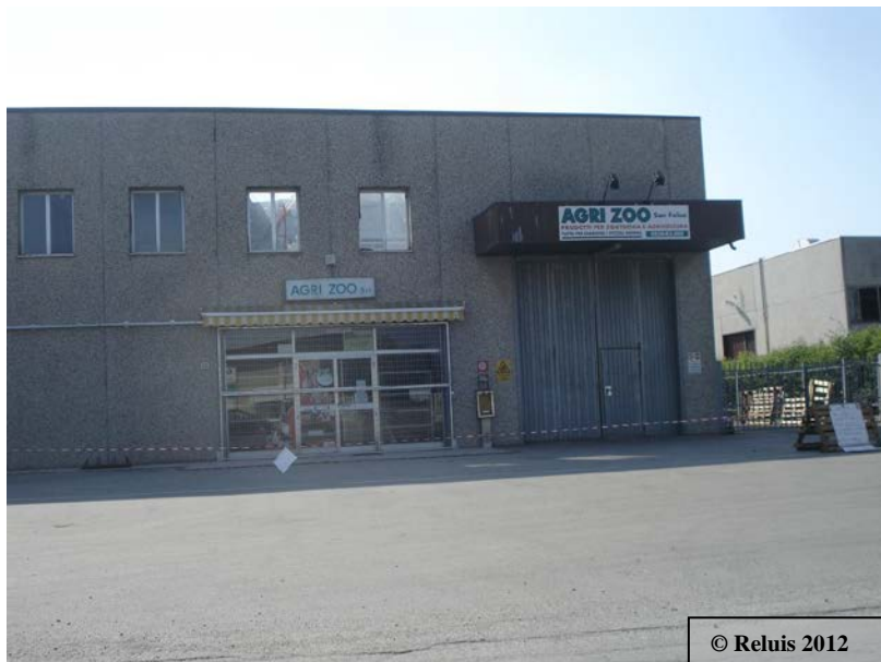
Figura 21 . Collasso copertura di un edificio prefabbricato
