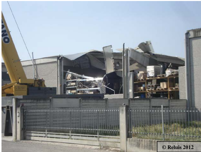
Figura 20 – Collasso di un edificio prefabbricato
