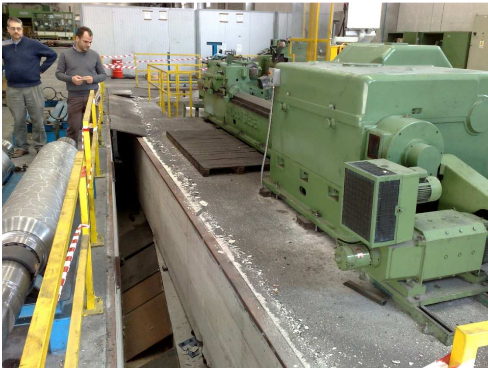
Figura 11 - Spostamento permanente di un blocco per l'isolamento dalle vibrazioni ambientali di un'apparecchiatura industriale (Foto dell'Arch. A. Di Nunzio).
