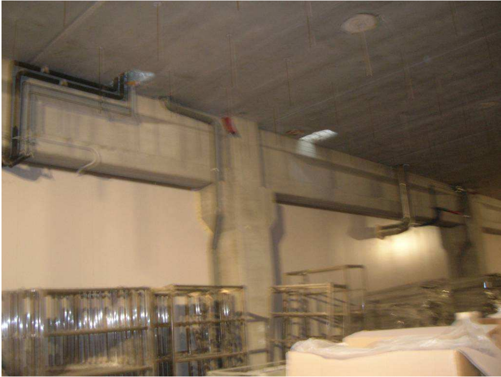
Figura 19 - Struttura del capannone industriale adibito alla produzione (foto dell'ing. A. Zambrano).
