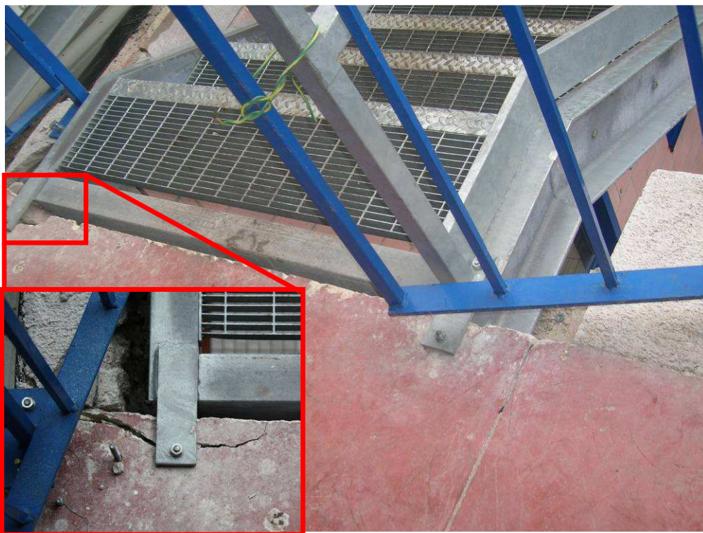
Figura 24 - Collegamento scala in acciaio-capannone industriale (foto dell'ing. A. Zambrano & F. Giordano).
