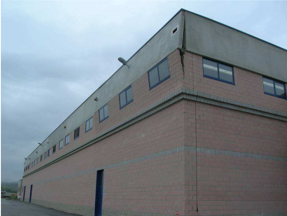
Figura 25- Velette fuori piano in sommità dell'edificio nelle facciate orientate est-ovest (foto dell'ing. A. Zambrano).
