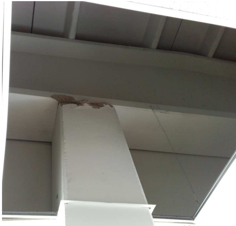
Figura 4 - Effetti di Martellamento fra capriata e pilastro centrale(Foto dell'Arch. A. Di Nunzio)
