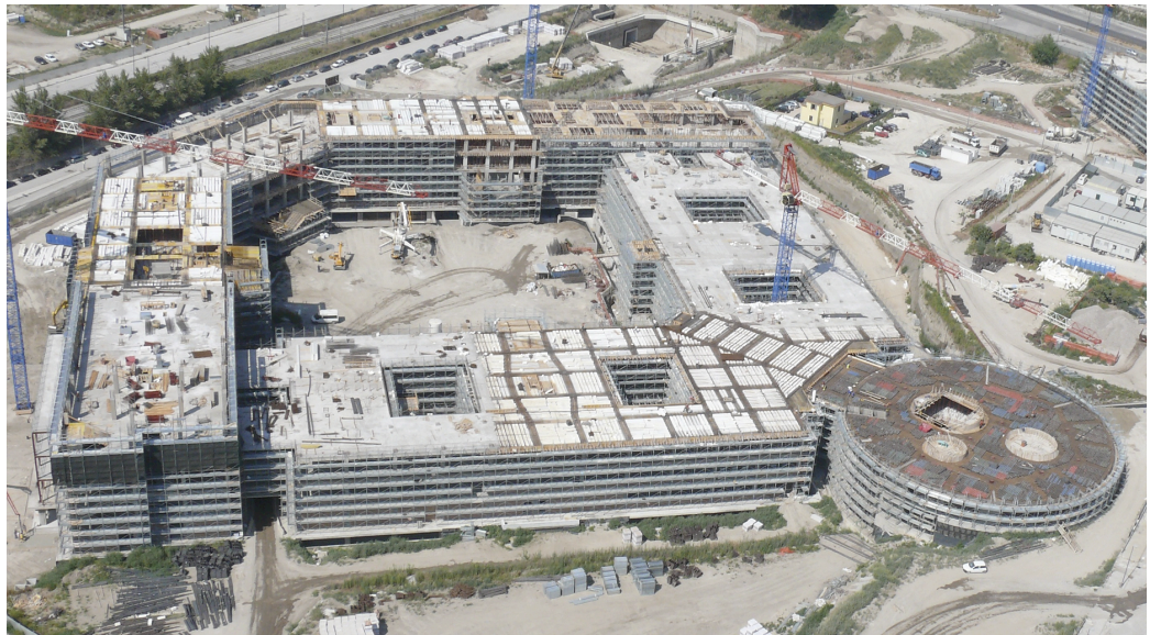
Fig. 15 Immagine del cantiere dell'Ospedale del Mare e disaggregazione della pericolosità sismica per il valore di a_g con periodo di ritorno T_R = 140 anni (INGV).
