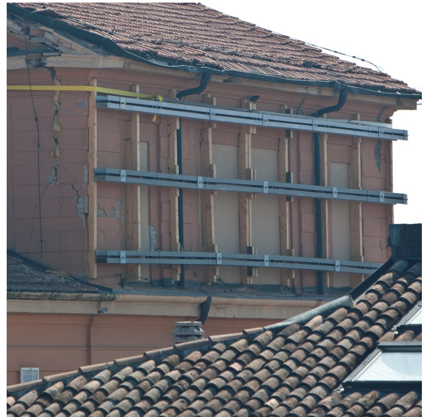
Messa in sicurezza del Teatro di Concordia (MO)
