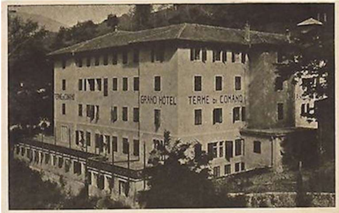
Figura 2: Foto storica del 1960, lato est dell'edificio
