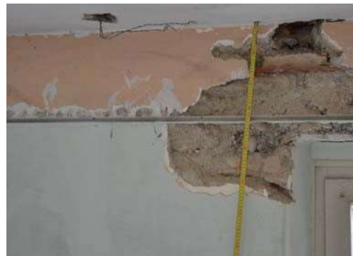
(b) Fascia in mattoni e malta di calce con cordolo
