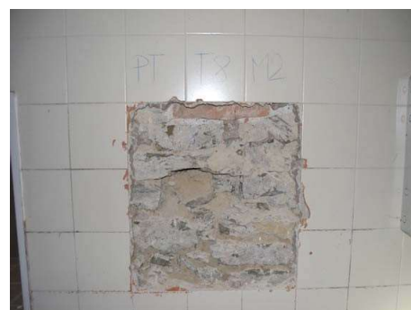
Figura 18: Muratura piano terra
