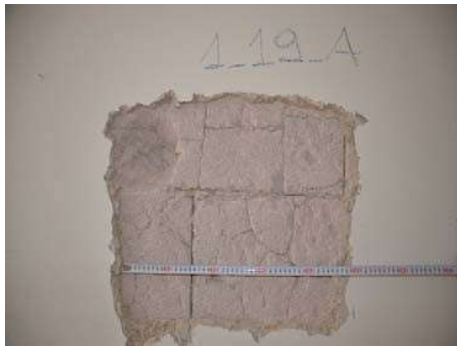
Figura 19: Muratura piano primo
