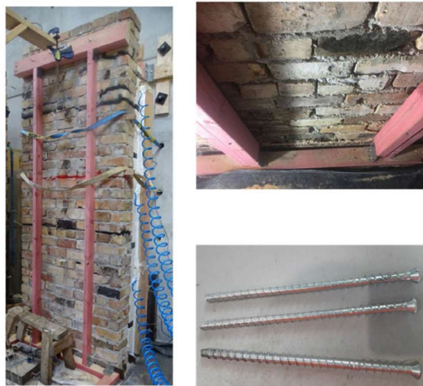
Figura 167: Connettori utilizzati per gli strong-backs sulla muratura in mattoni [44]
