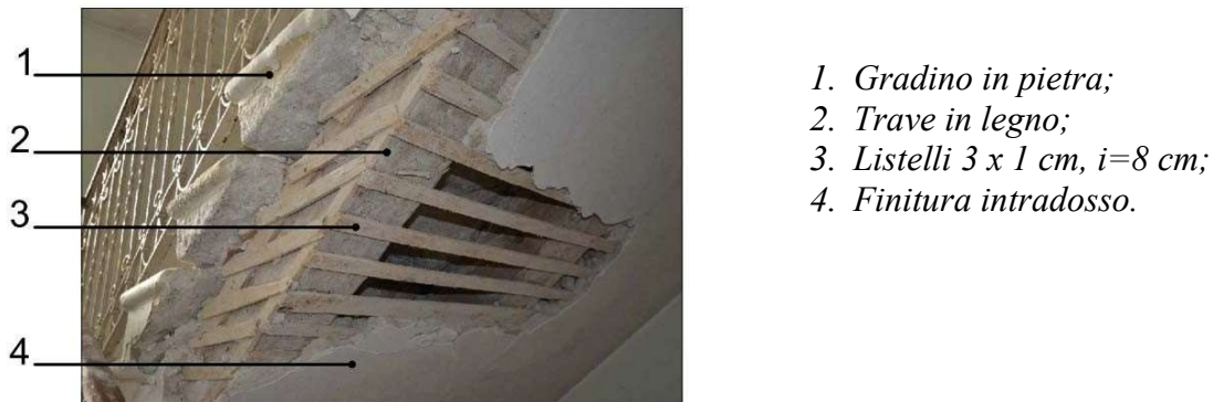
Figura 37: Definizione elementi scala principale
