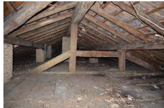
Figura 32: Copertura cono visuale 2
