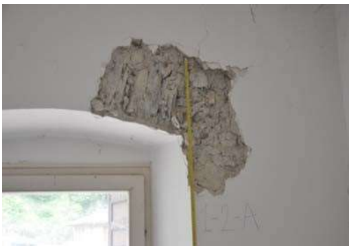
(a) Fascia in pietra e malta di calce
