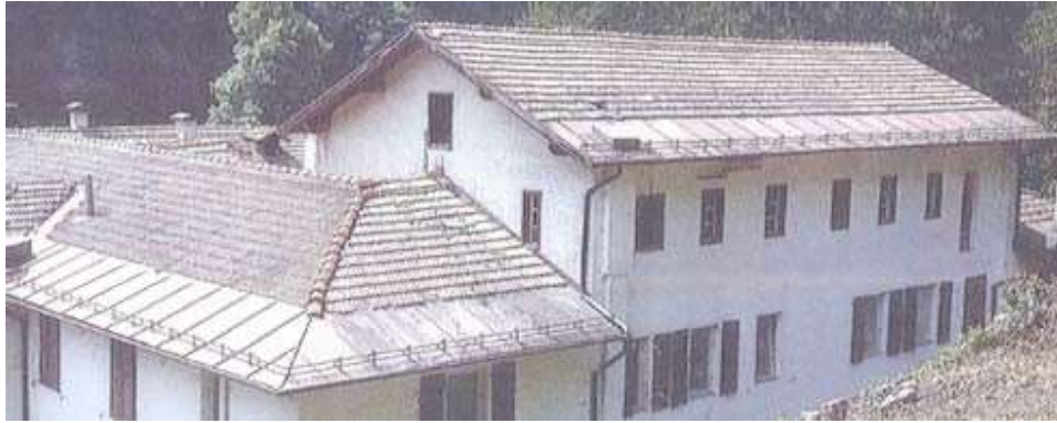
Figura 16: Foto sopraelevazione sul lato nord
