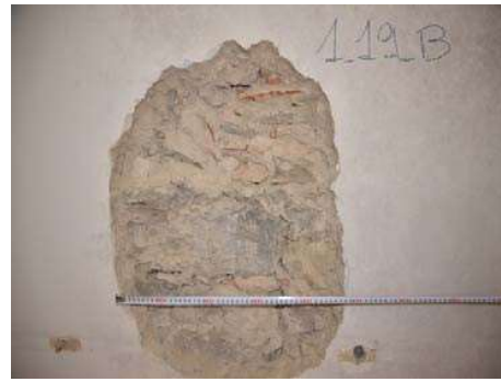
Figura 20: Muratura piano primo
