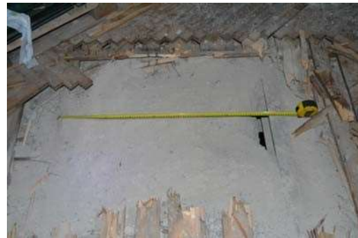
Figura 27: Solaio piano terra, estradosso
