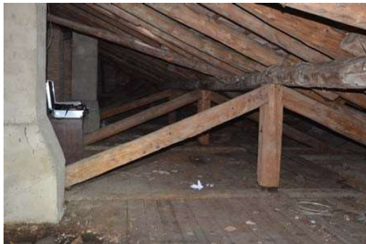
Figura 31: Copertura cono visuale 1
