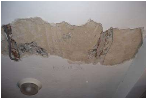
Figura 26: Solaio piano terra, intradosso
