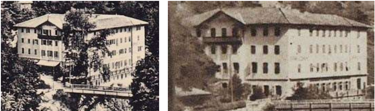
Figura 14: Foto storiche del 1950 con sopraelevazione del terzo piano (cortesia di Severino Riccadonna)
