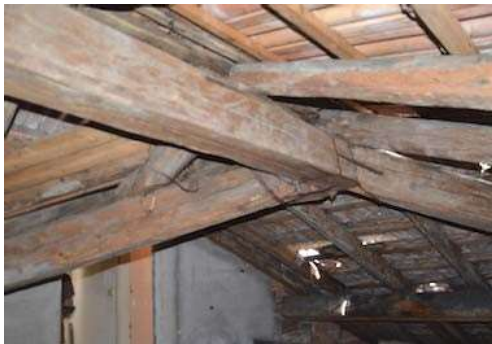
Figura 34: Nodi a sbalzo tra colmo e diagonale
