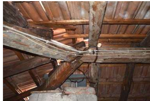
Figura 34: Nodi a sbalzo tra colmo e diagonale
