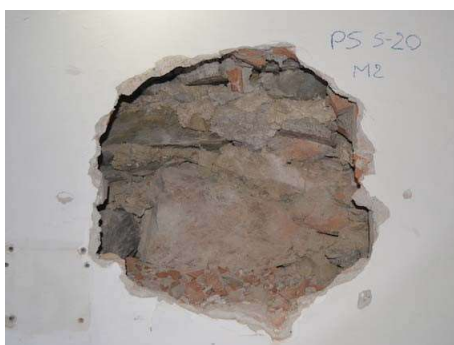
Figura 17: Muratura piano interrato
