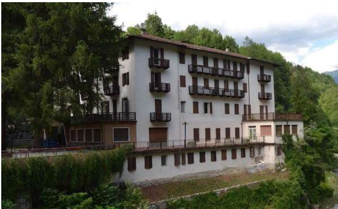
Figura 3: Foto attuale del lato sud dell'edificio
