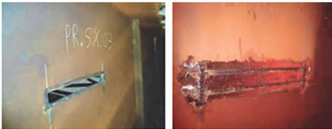
Figura 16. Prelievo di un campione dalla trave principale, e successivo ripristino mediante saldatura in opera
