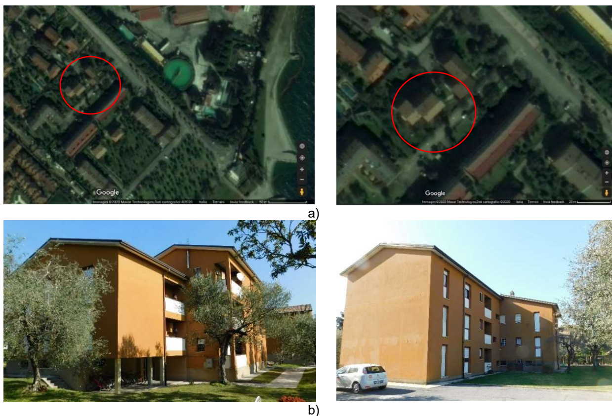
Figura 4 – a) Ortofoto con identificazione dell'edificio (©GoogleMaps), b) viste prospettiche dell'edificio (©GoogleMaps).
