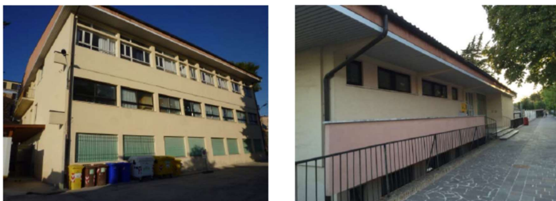
Figura 1.2: Vista n°1 (a) e vista n°2 (b) dell'edificio.
