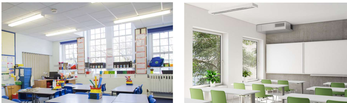
Figura 4.84. Interventi di Relamping (a) e Ipianto di ventilazione VMC (b)
