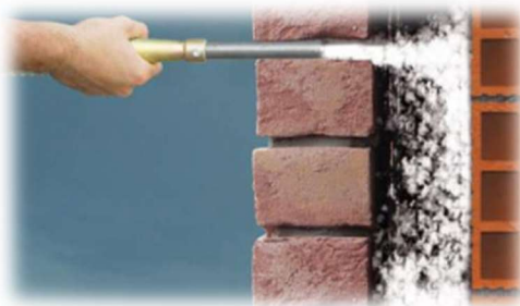
Figura 4.20: Insufflaggio delle pareti verticali.
