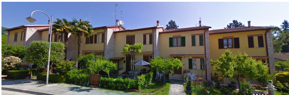
Figura 1-2: Vista esterna del caso studio prima del terremoto (Valluzzi et al., 2021).
