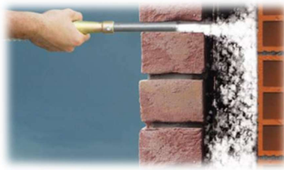
Figura 4-22: Insufflaggio delle pareti verticali.
